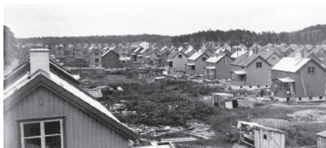
Enskedefältet under byggnad. Foto: Andersson 1932. SSM
